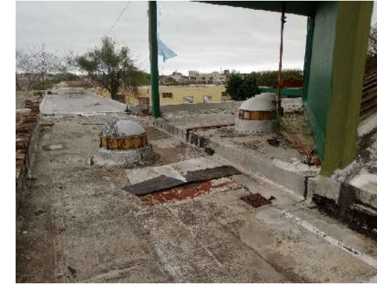
Foto 1 Cubierta de galerías: losas de HºAº con carpetas de cemento y membranas asfálticas
