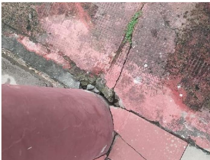
En el caso de pisos de cemento rodillados, se picará un sector generosamente mayor al deteriorado, y se completará con carpetas 1:3 y ferrites al tono. Se utilizarán retardantes de fragüe al momento del tendido de las carpetas sobre contrapisos existentes.
