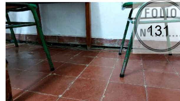
Levantado de contrapiso y piso en comedor/aula
