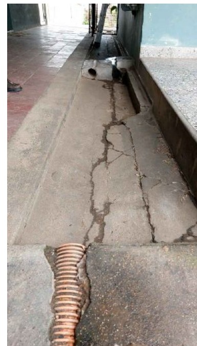
Desagües pluviales a entubar
