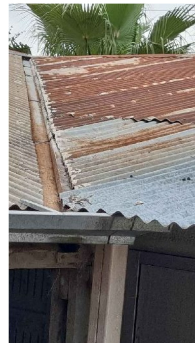
Retiro cubierta de chapa
