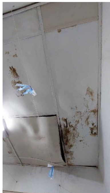
Demolición y retiro de cielorraso en aula jardin
