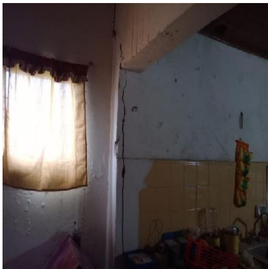
En estructuras de hormigón.
