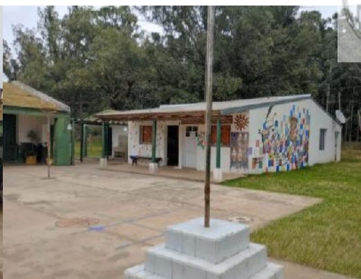
Techos nuevos de zinc.
