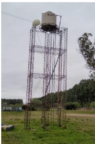
Tanque de Reserva de la Escuela 17
