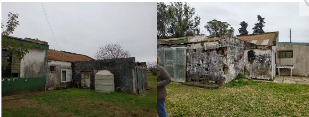
Deposito a demoler.
